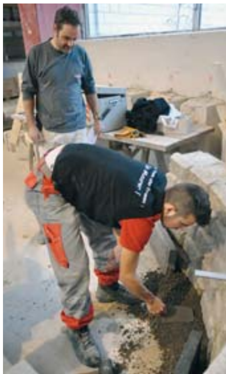
Chefinstruktor Thomas Arpasi beobachtet den Kursteilnehmer Marco Eugster beim Erstellen eines Stellriemens.
